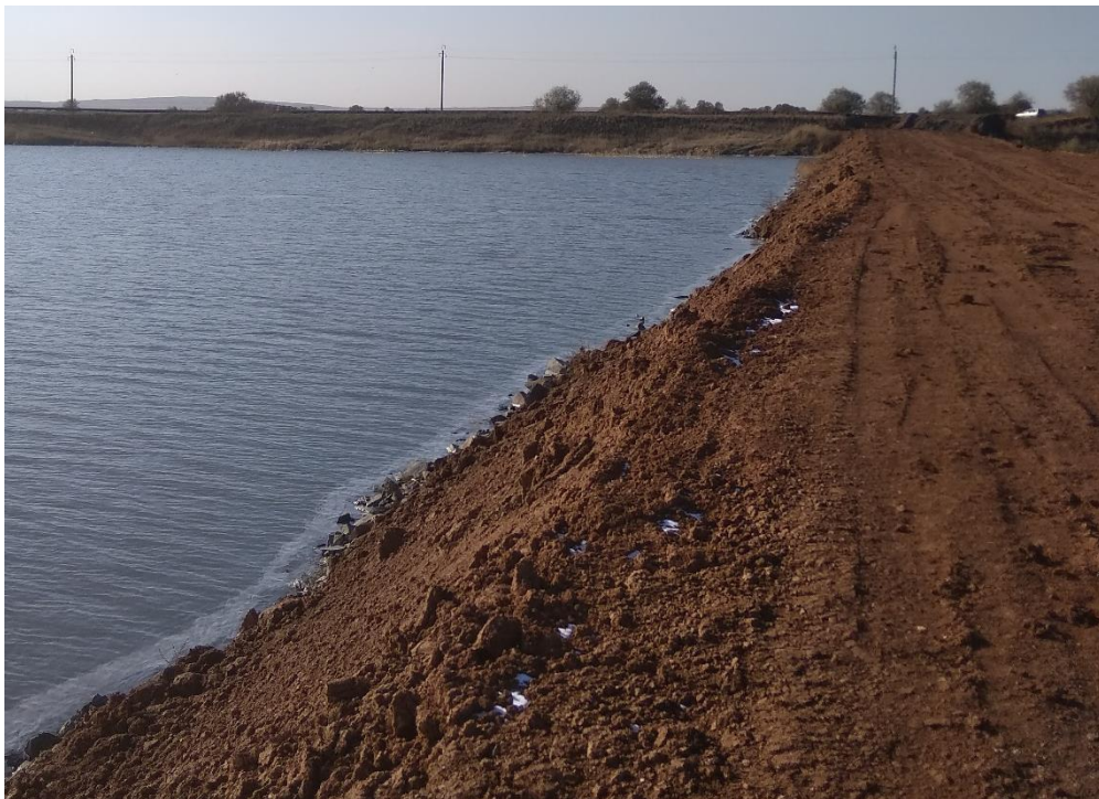
Рисунок 3 – Общий вид тела дополнительной оградительной дамбы золоотвала КарГРЭС-1 после проведенных работ
